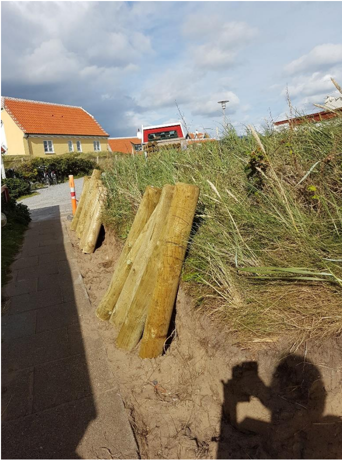
12/9 2017 Opstart palisade indgang A
